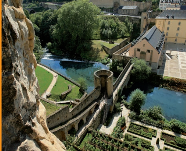
Casemates du Bock: vue des meurtrières
